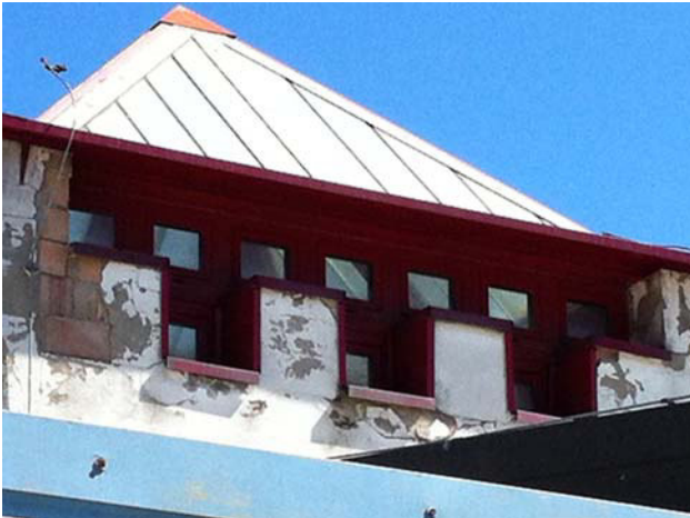
Torretta (esterno): evidenti distacchi di intonaco dovuti alle acque piovane (laterizio a vista)
