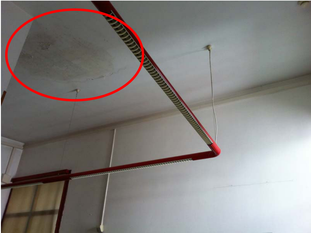
Distacco intonaco in un solaio di copertura (percolazioni acque piovane)
