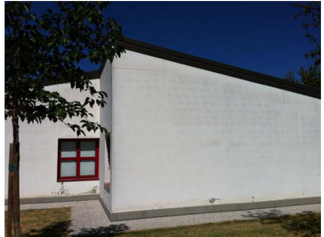
Distacco intonaco alla base delle pareti in laterizio e setolature in corrispondenza del cordolo in c.a.
