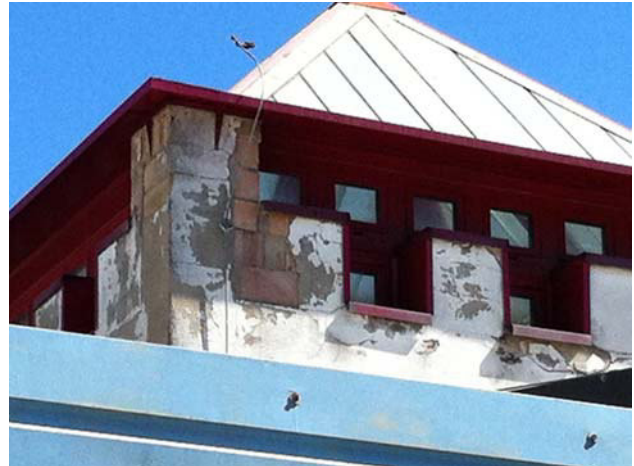
Torretta (esterno): evidenti distacchi di intonaco dovuti alle acque piovane (laterizio a vista)
