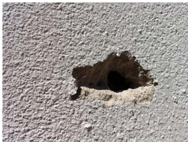
Presenza di cordolo in c.a. sulle pareti in muratura in corrispondenza dello sbarco del solaio di copertura
