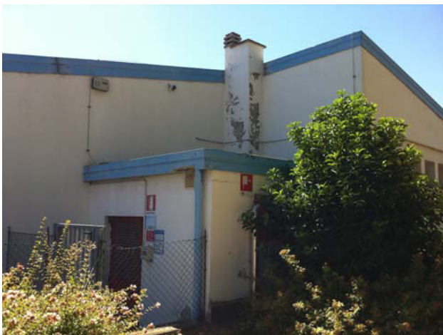
Distacco intonaco canna fumaria, setolatura tra cordolo e parete in laterizio (centrale termica), distacco intonaco alla base e in sommità delle pareti in laterizio lungo il perimetro dell'edificio
