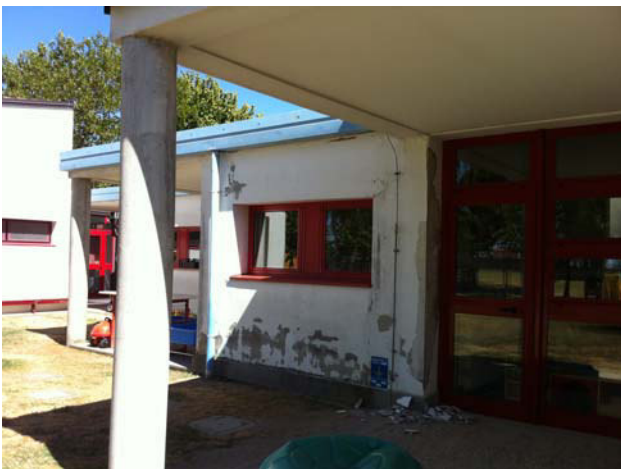
Evidenti distacchi di intonaco alla base delle pareti e in corrispondenza della architrave con fondello in laterizio
