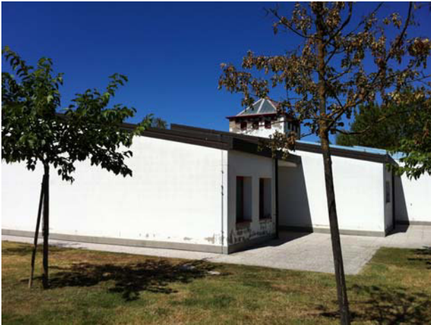
Distacco intonaco alla base delle pareti in laterizio e setolature in corrispondenza del cordolo in c.a.
