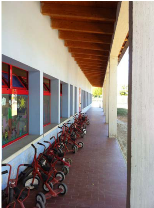
Facciata Nord: portico realizzato con telaio in c.a. monodirezionale non collegato alla copertura
