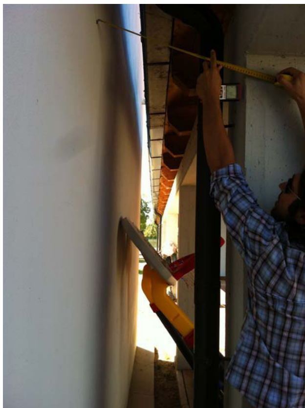
Giunto tra l'Ampliamento e il Centro Servizi - Giunto tra le coperture dell'Ampliamento (legno) e della Scuola Materna (latero-cemento)
