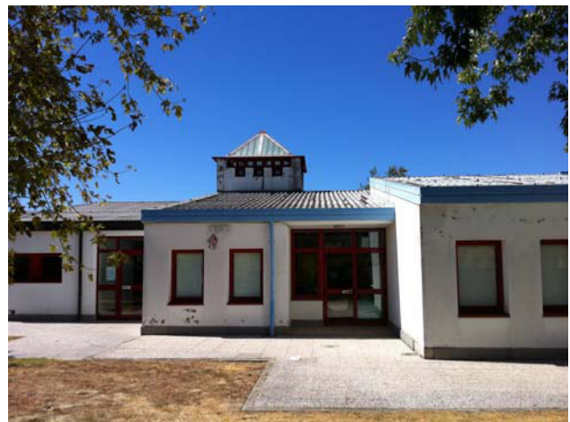
Distacco intonaco canna fumaria, setolatura tra cordolo e parete in laterizio (centrale termica), distacco intonaco alla base e in sommità delle pareti in laterizio lungo il perimetro dell'edificio
