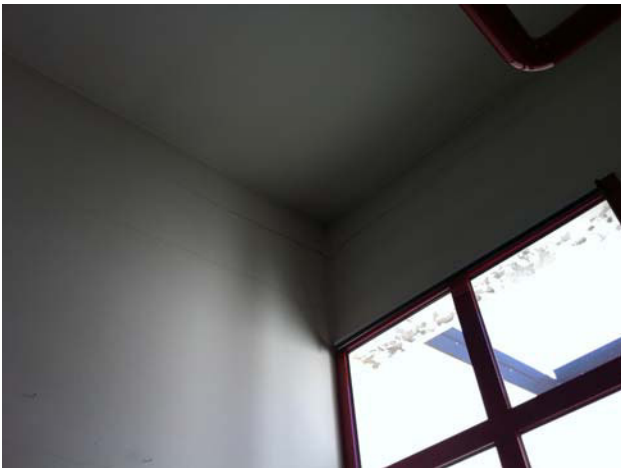
Evidenti setolature in corrispondenza del cordolo in c.a. delle pareti (interno ed esterno)
