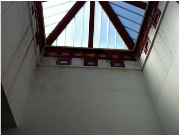
Torretta (interno): evidenti distacchi di intonaco dovuti alle acque piovane e setolature in corrispondenza di cordoli in c.a.
