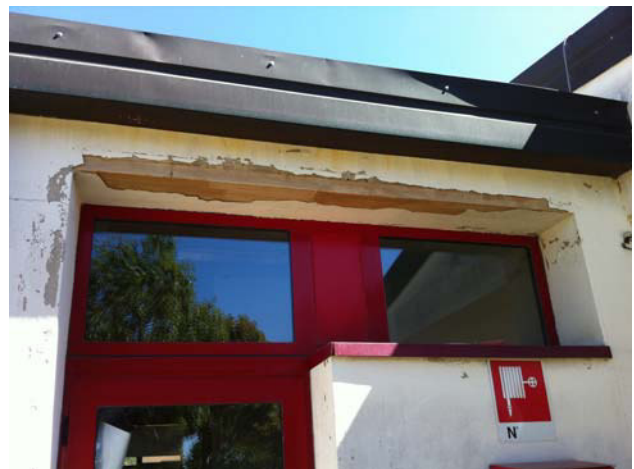
Evidenti distacchi di intonaco alla base delle pareti e in corrispondenza della architrave con fondello in laterizio
