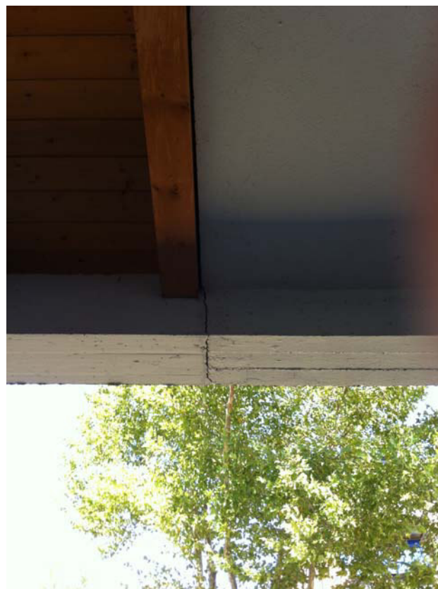
Giunto tra l'Ampliamento e il Centro Servizi - Giunto tra le coperture dell'Ampliamento (legno) e della Scuola Materna (latero-cemento)
