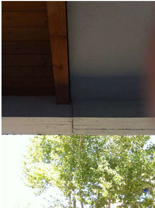
Giunto tra le coperture dell'Ampliamento (legno) e della Scuola Materna (latero-cemento)
